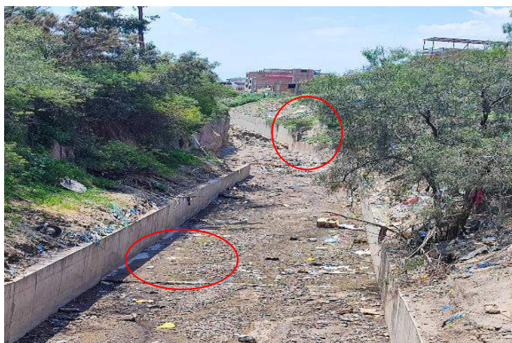
IMAGEN 01: SE OBSERVA LA MARGEN IZQUIERDA DE EL MURO CAMBIA DE ALTURA HABIENDO UNA PENDIENTE POSITIVA SE PUEDE REQUERIR DE DISIPADORES DE ENERGIA AGUAS ARRIBA, ASI COMO SE OBSERVA EL ALTO DEL MURO SE MUESTRA LA BASE DE CONCRETO EN ESTE TRAMO EVIDENCIANDO LA POCA ALTURA DEL MURO
